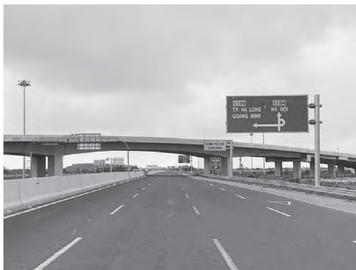
写真 4 ベトナム・ハノイーハイフォン高速道路。2015 年 12 月に開通し、片道 3 車線で快適な高速道路。（出所）2019 年 4 月 畢世鴻撮影。
