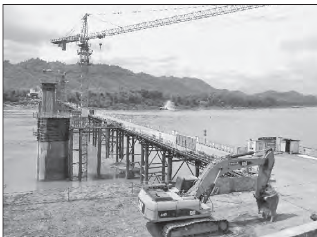
写真 7 急ピッチで建設されている中国・ラオス鉄道。ラオスの古都ルアンパバーンのメコン川をわたる鉄道橋であり、その建設工事が 2019 年 7 月下旬に完成した。中国・ラオス鉄道は 2021 年に全線開通する見通しである。 （出所）2018 年 5 月 畢世鴻撮影。
