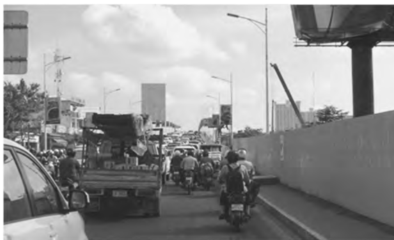
写真 3 カンボジア・プノンペン市内を通る「日本・カンボジア友好橋」。1963 年に建造され、1991 年、2018 年と二度の補修工事を経て現在も使用されている。この橋のすぐ隣には、2014 年に中国の援助で新たに建造された「中国・カンボジア友好橋」がある。メコン広域開発の発展を象徴する橋といえるだろう（2018 年 1 月、筆者撮影）。
