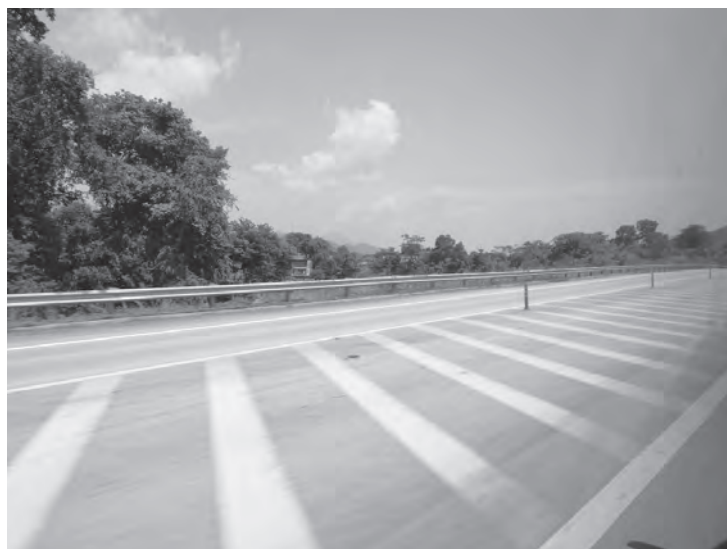
写真 5 ベトナム・ラオカイーハノイ高速道路。2014 年 9 月に開通し、すべての区間が一方通行ではない準高速道路。（出所）2019 年 8 月 畢世鴻撮影。
