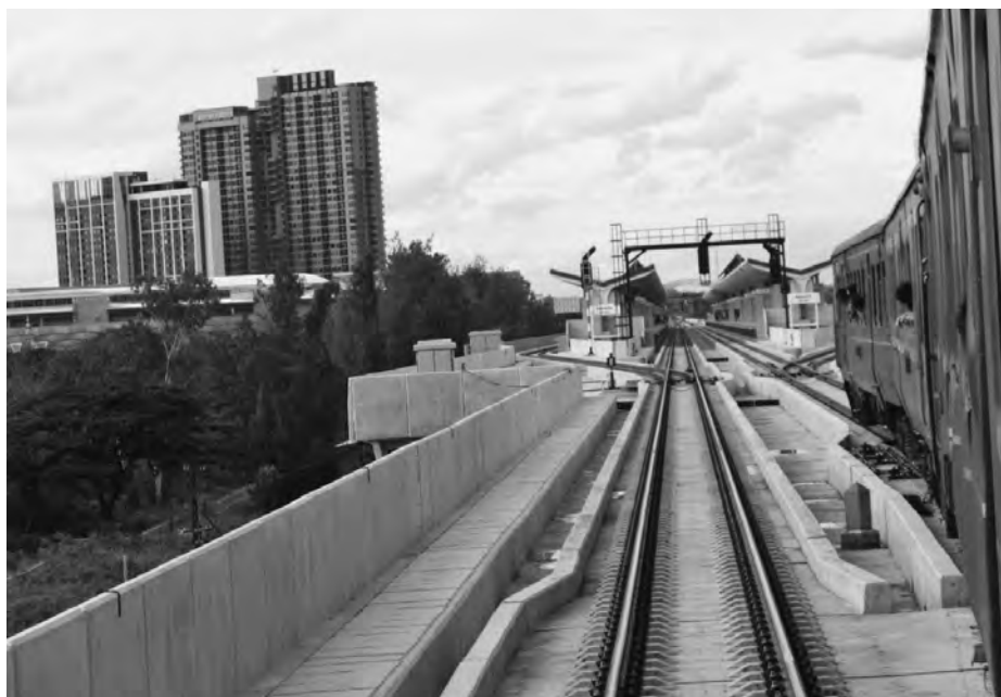
写真 5 完成したコーンケン付近の複線化工事（2019 年 8 月）
