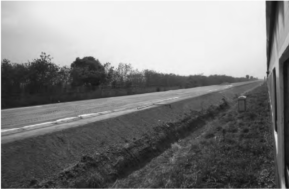
写真 1 第 1 工区の建設状況（2019 年 3 月）
